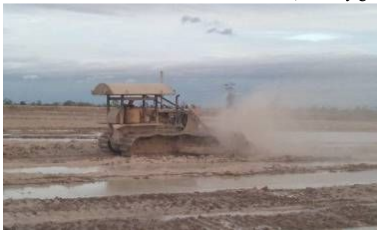
Hình 2. Máy ủi đang san đất
