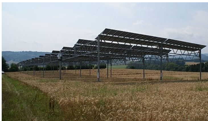
Hình 2. Cơ sở nông quang điện (cơ sở Agri-PV) tại cộng đồng nông trại Heggelbach, Bang Baden-Wuerttemberg, CHLB Đức. (Nguồn: Asumnipal/Wikimedia Commons)
